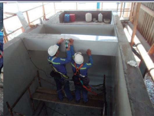
Recubrimiento de tanques
